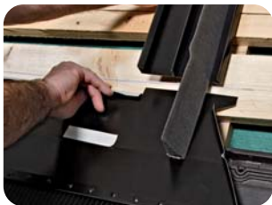
12. Instalarea șorțului de etanșare
