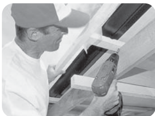
Demontajul ambalajului de pe panoul solar
