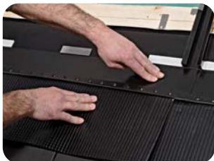
13. Instalarea șorțului de etanșare
