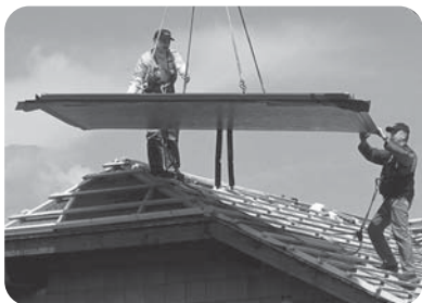
Panoul se ridică în poziție orizontală pe acoperiș
