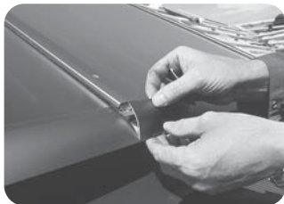
Poziționați cu precizie profilul clips din aluminiu și apăsați în direcția șipcii din aluminiu
