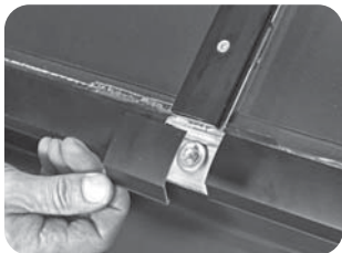
Profilele clips din aluminiu se agăță în primă fază în partea inferioară a profilului de aluminiu
