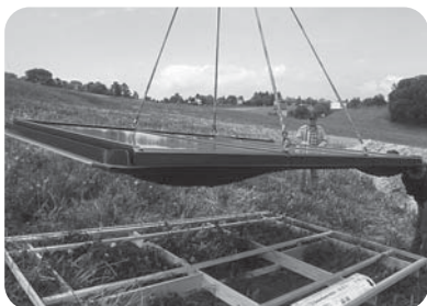
Ridicarea panoului solar de pe paletul de transport
