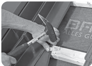
Rama de etanșare din tablă se fixează cu dămlele de tablă, astfel încât țiglele să stea pe șipcle suport cât mai bine
