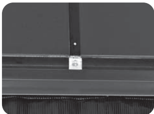
Gata fixată cu șuruburi
