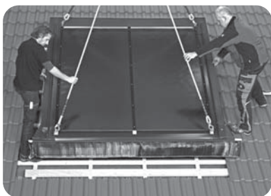
Panoul se ridică în poziție orizontală pe acoperiș
