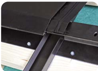
7. Instalarea ramei de etanșare superioară
