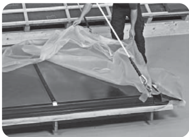
Tăierea foliei și despachetarea colectorului
