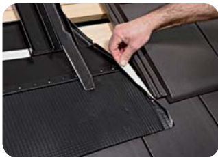
14. Instalarea șorțului de etanșare*
