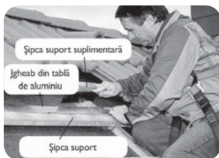
În caz de necesitate montați șipca suplimentară
