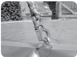
Montajul corzilor pe panou
