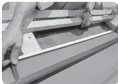
Montajul profilului de aluminiu
