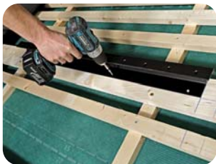
4. Instalarea ramei de fixare superioare
